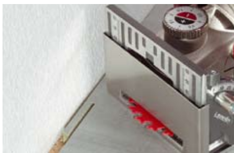
schaduwvoegen snijden
